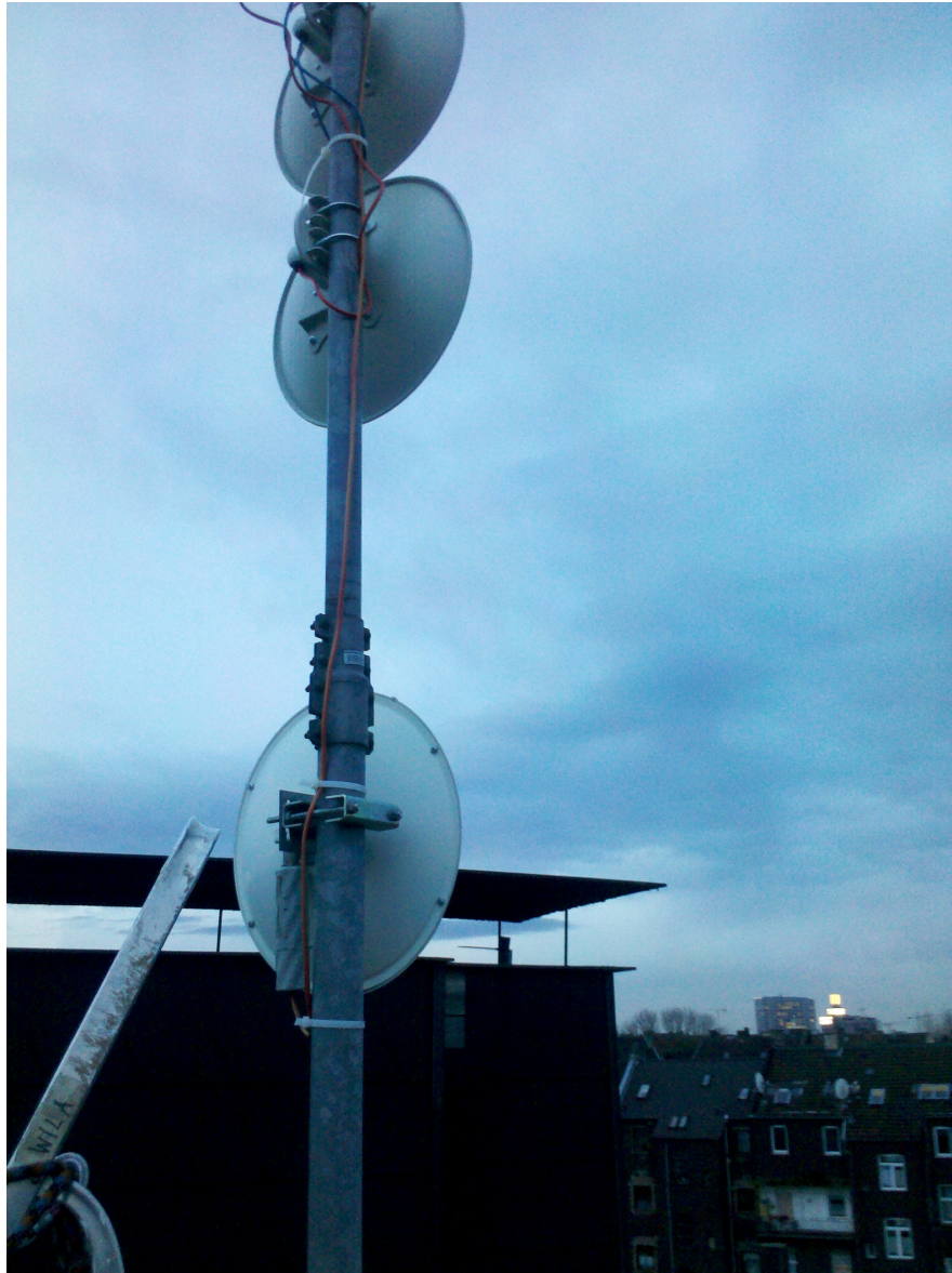
Abbildung 8.1: Parabolantennen auf dem Dach des WilaDo
